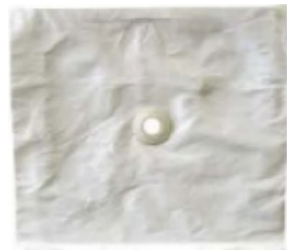
Doble tela de filtro tipo clip después de la instalación
